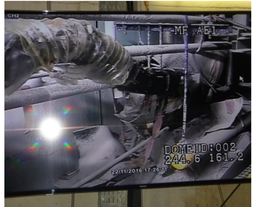
PREDATOR en fonctionnement à l'intérieur de la casemate
