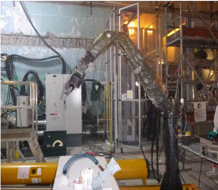
En phase de test, en dehors de la casemate
