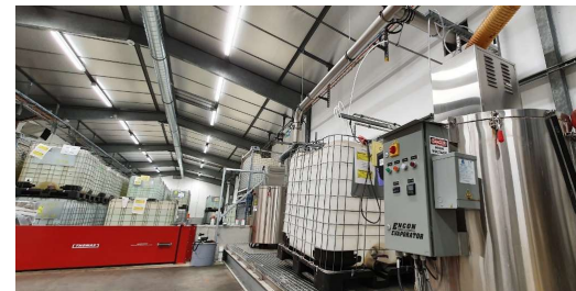
Fig. Cuves plastique ayant contenu de l'eau tritiée
